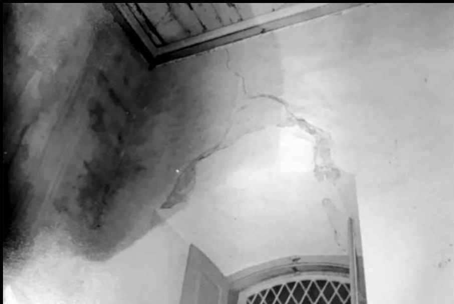
Fig. 71 – Registro das obras de restauro, promovidas pelo SPHAN entre 1983 e 1985, que objetivaram estabilizar um abatimento existente na torre do relógio, localizado no frontispício da Matriz e cujas consequências já se faziam sentir na janela do coro, tanto interna quanto externamente Fonte: Arquivo Eclesiástico da Paróquia Nossa Senhora do Pilar de São João del-Rei (AEPNSP-SJRD)
