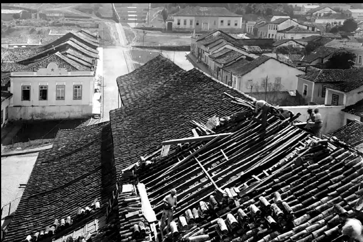
Fig. 65 – Foto do início da intervenção na cobertura da nave da Matriz de Nossa Senhora do Pilar. Vê-se parcialmente à esquerda, a escada e os andaimes montados pela equipe técnica do SPHAN, para iniciar a Campanha de Restauração total da igreja, realizada entre os anos de 1955 e 1958 Fonte: Arquivo Eclesiástico da Paróquia Nossa Senhora do Pilar de São João del-Rei (AEPNSP-SJRD)
