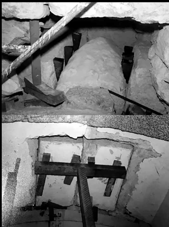
Figs. 72 e 73 – Registro do processo das obras de estabilização na padieira de cantaria em forma de arco abatido, da janela direita do coro, durante as obras de intervenção e restauro do frontispício da Matriz, promovidas pelo SPHAN entre 1983 e 1985 Fonte: Arquivo Eclesiástico da Paróquia Nossa Senhora do Pilar de São João del-Rei (AEPNSP-SJRD)
