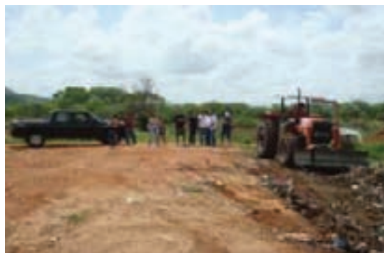
Restolho sendo colocado nas valas e coberto com argila
