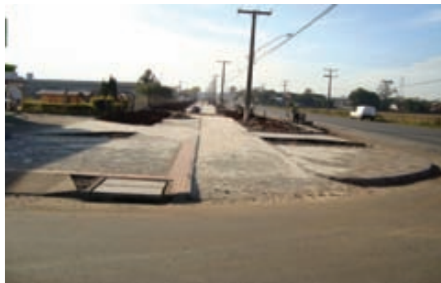
Início das obras na Rodovia Gabriel Arns
