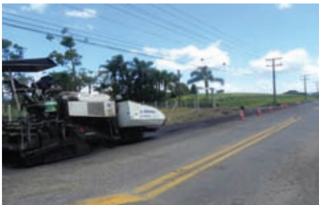
Início das obras na Avenida 25 de julho
