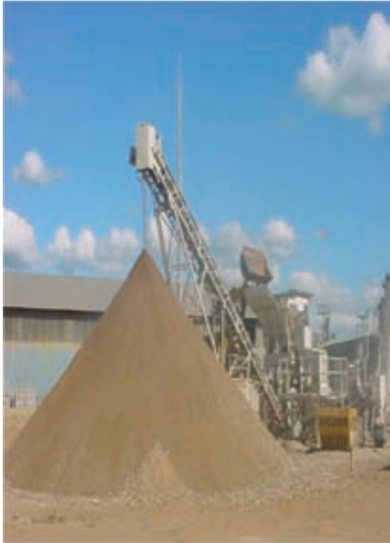
Usina de Reciclagem de Resíduos da Construção Civil
