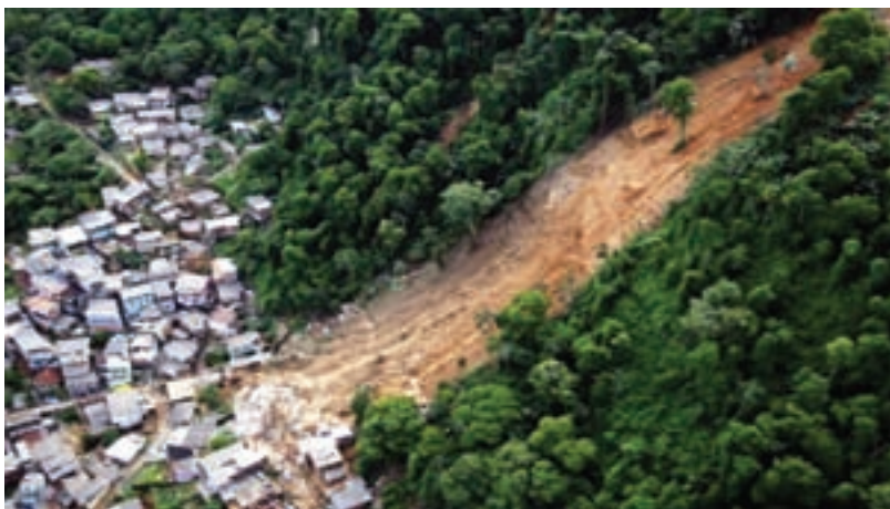
Deslizamento de encosta sobre comunidade (fonte: PCRJ)
